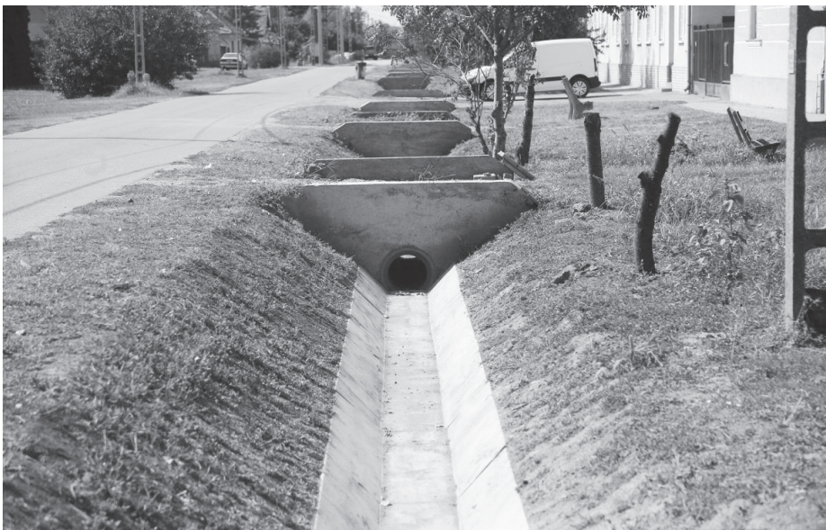
Befejeződött a csapadékvíz-elvezető hálózat építése.
